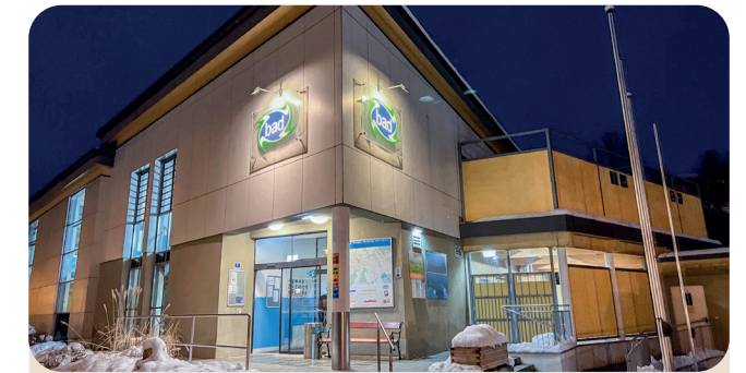
Schwimmbad in Betrieb seit 2010 Einsparung 220 kWh/tägl.
